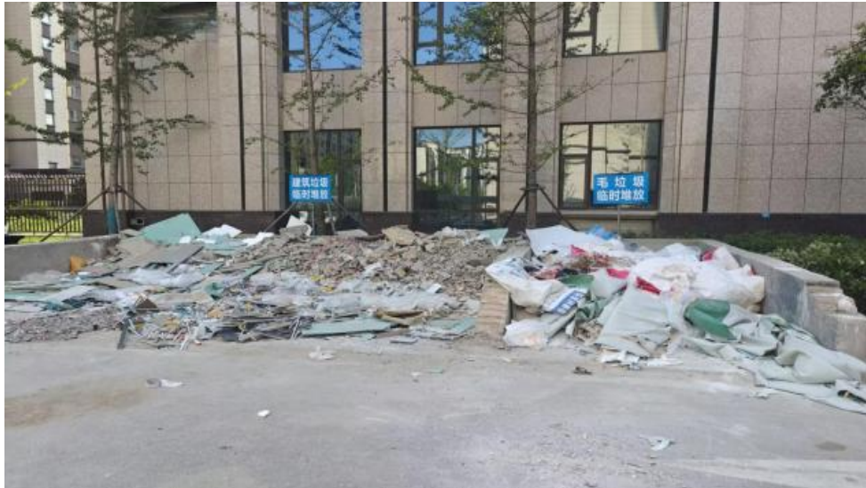
图3.3-1装修垃圾收集点现场照片
