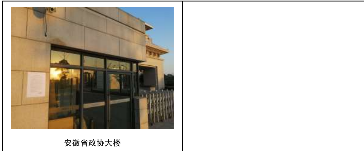
图 5 沿线张贴公告照片
