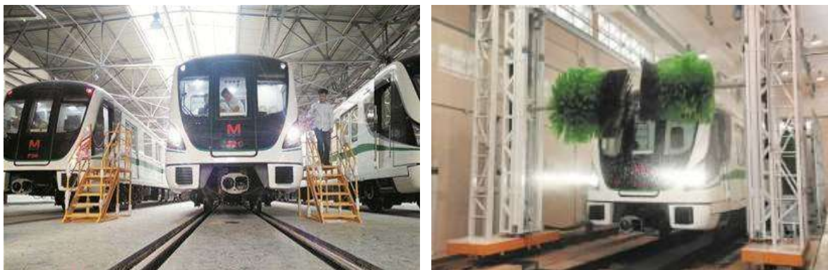
图 4.4-5 既有武汉地铁停车列检及洗车现场
