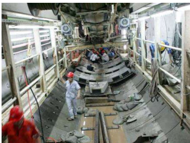
盾构法隧道内部施工现场
