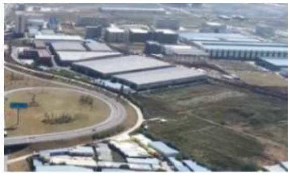
出入线范围航拍图
