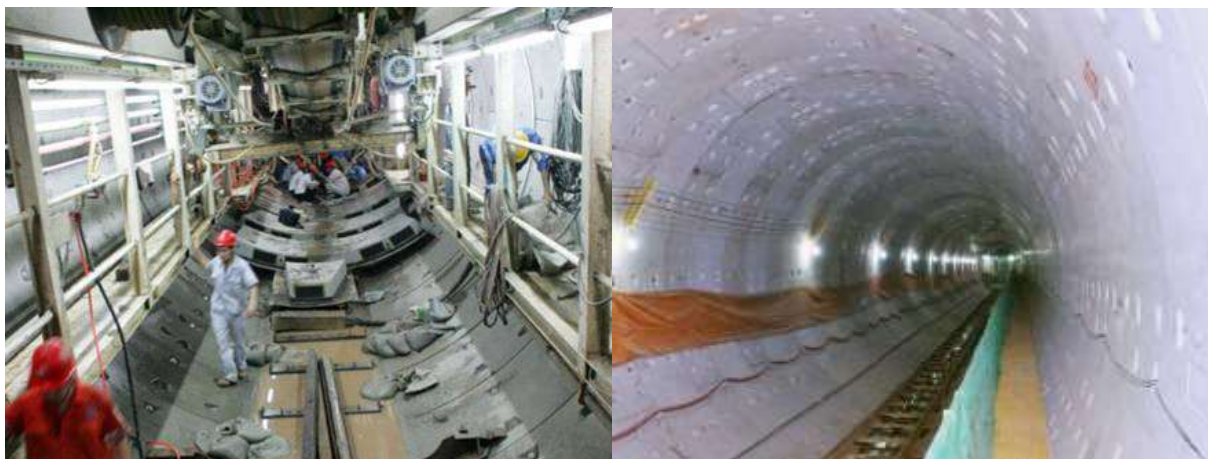
盾构法隧道内部施工现场
