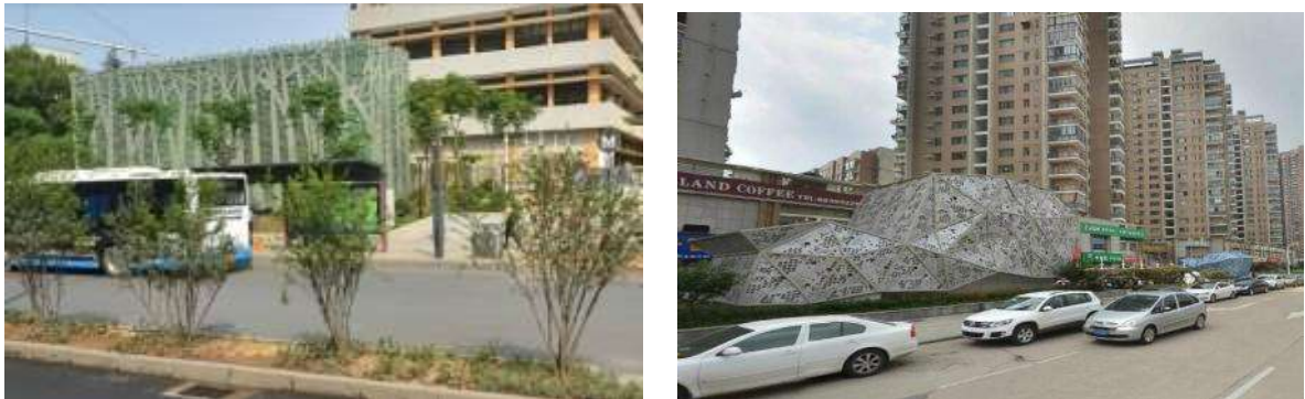
图 4.3-1 车站风亭、冷却塔景观
