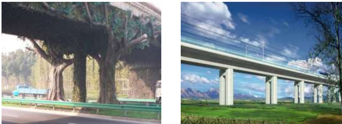
图 4.3-2 高架区间景观
