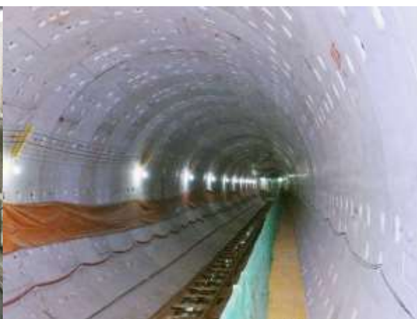
盾构法隧道施工现场（建成后）
