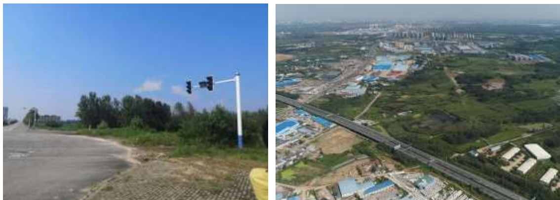
图 3.2-8 岗集主变电所和新桥大道主变电所现状景观图
