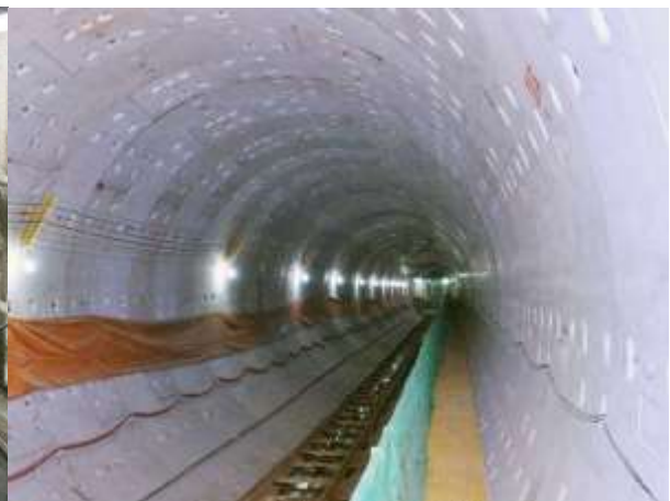
盾构法隧道施工现场（建成后）
