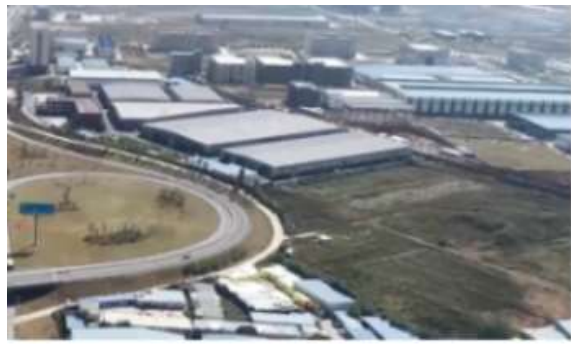
出入线范围航拍图
