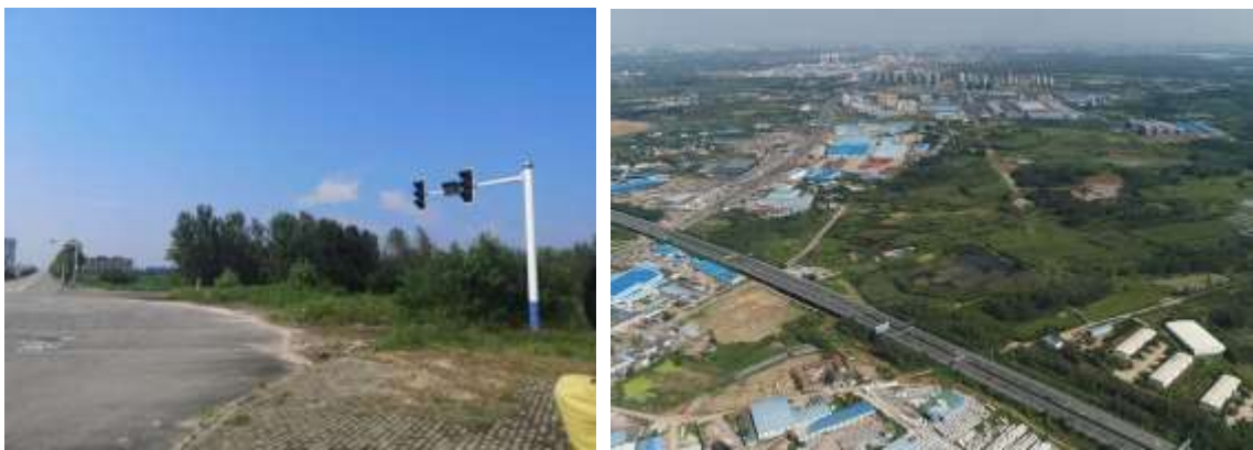
图 3.2-8 岗集主变电所和新桥大道主变电所现状景观图
