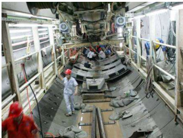
盾构法隧道内部施工现场
